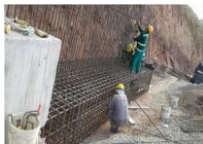
FOTO 1. PODEMOS OBSERVAR EL PROCESO PARA LA INSTALACION DEL REFUERZO EN EL MURO SOBRE CAISSON DEL K3+400 COSTADO IZQUIERDO.
