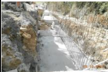
FOTO 3. SE APRECIA EL REFUERZO Y LA CONSTRUCCION DEL MURO EN EL K8+450 COSTADO IZQUIERDO.
