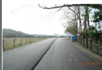
FOTO 6. PODEMOS APRECIAR LA INSTALACION DE LA SEGUNDA CAPA DEL COSTADO IZQUIERDO DEL ASFALTO TIPO MDC-19.
