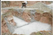
FOTO 5. PROCESO DE CONSTRUCCION DE ALCANTARILLA DE 36" EN EL K10+400
