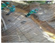
FOTO 2. APRECIAMOS LA INSTALACION DEL REFUERZO PARA EL BOX DEL K0+130 COSTADO IZQUIERDO DE LA VIA.
