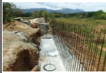
FOTO 4. PROCESO DE CONSTRUCCION DEL MURO DE ACOMPAÑAMIENTO PARA EL BOX COULVERT EN EL K9+880 COSTADO DERECHO DE LA VIA.
